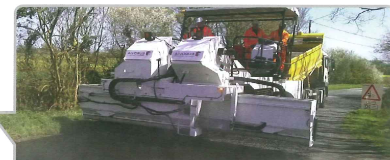
Une synergie entre Eurovia UK et Hubbard Group (États-Unis) a permis l'importation d'une technique de mise en œuvre grande largeur (6,50 m) en marche avant au Royaume-Uni.
